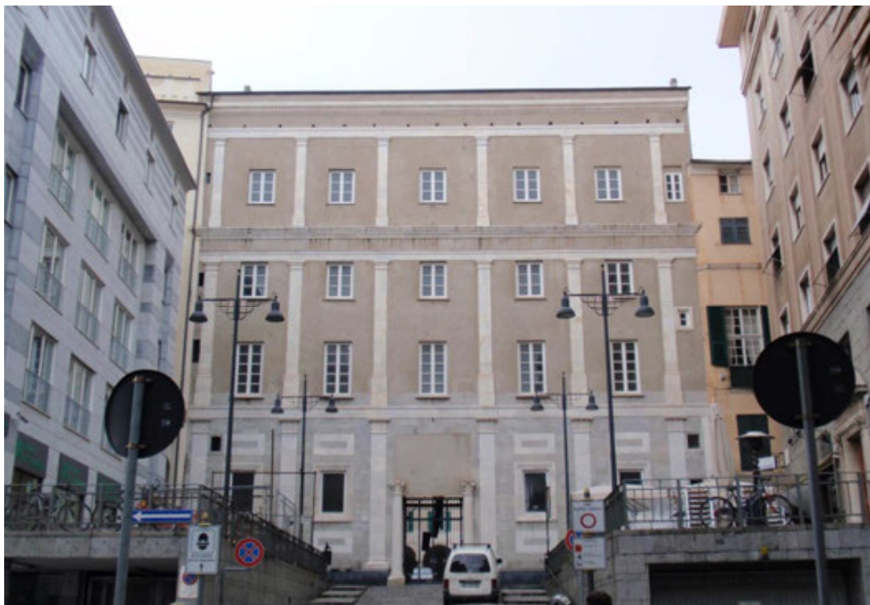
6- Facciata su Via Pia, concepita nel progetto originario di Giuliano da Sangallo
