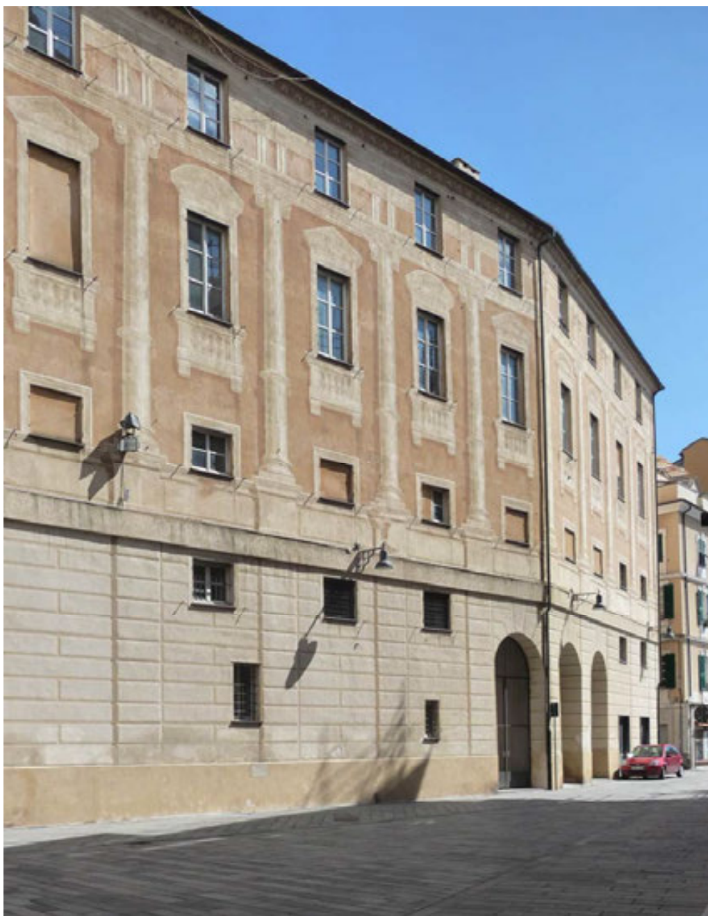
9- Vista della facciata prospiciente su Piazza Del Duomo
